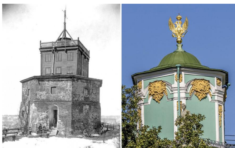
Телеграфная надстройка на башне Гедемина в Вильно и башенка центральной российской станции оптического телеграфа на Зимнем дворце. После ликвидации станции на ней вместо семафора установили скульптурное изображение государственного герба.
